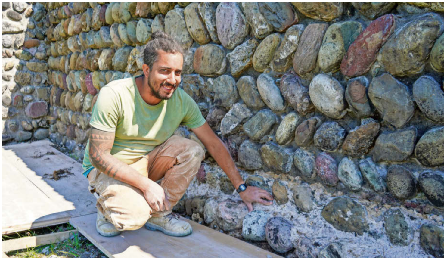
Fernando Hilber von der T. Neuweiler GmbH sorgt mit seinem Team dafür, dass das Römerkastell nicht weiter verfällt. Fotos: Lea Chiapolini
