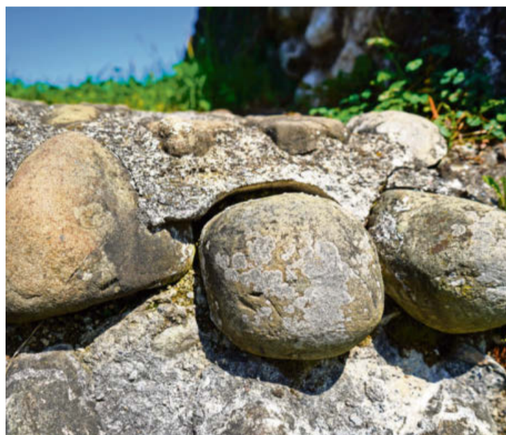
Durch Verwachsungen und Frostschäden haben sich viele Steine in den Mauern gelockert.
